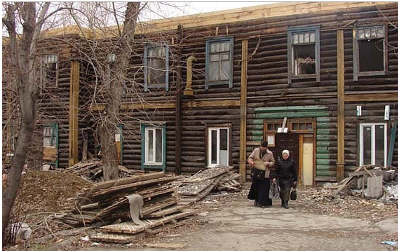
СТАРОЕ ДЕРЕВЯННОЕ здание, в котором проходят собрания — это будущий Дом сестринского ухода с домовою церковью свт. Луки Симферопольского. Сейчас там ведутся ремонтные работы
